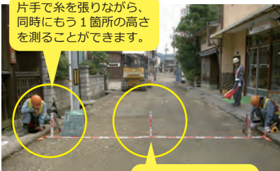
片手で糸を張りながら、 同時にもう1箇所の高さ を測ることができます。
